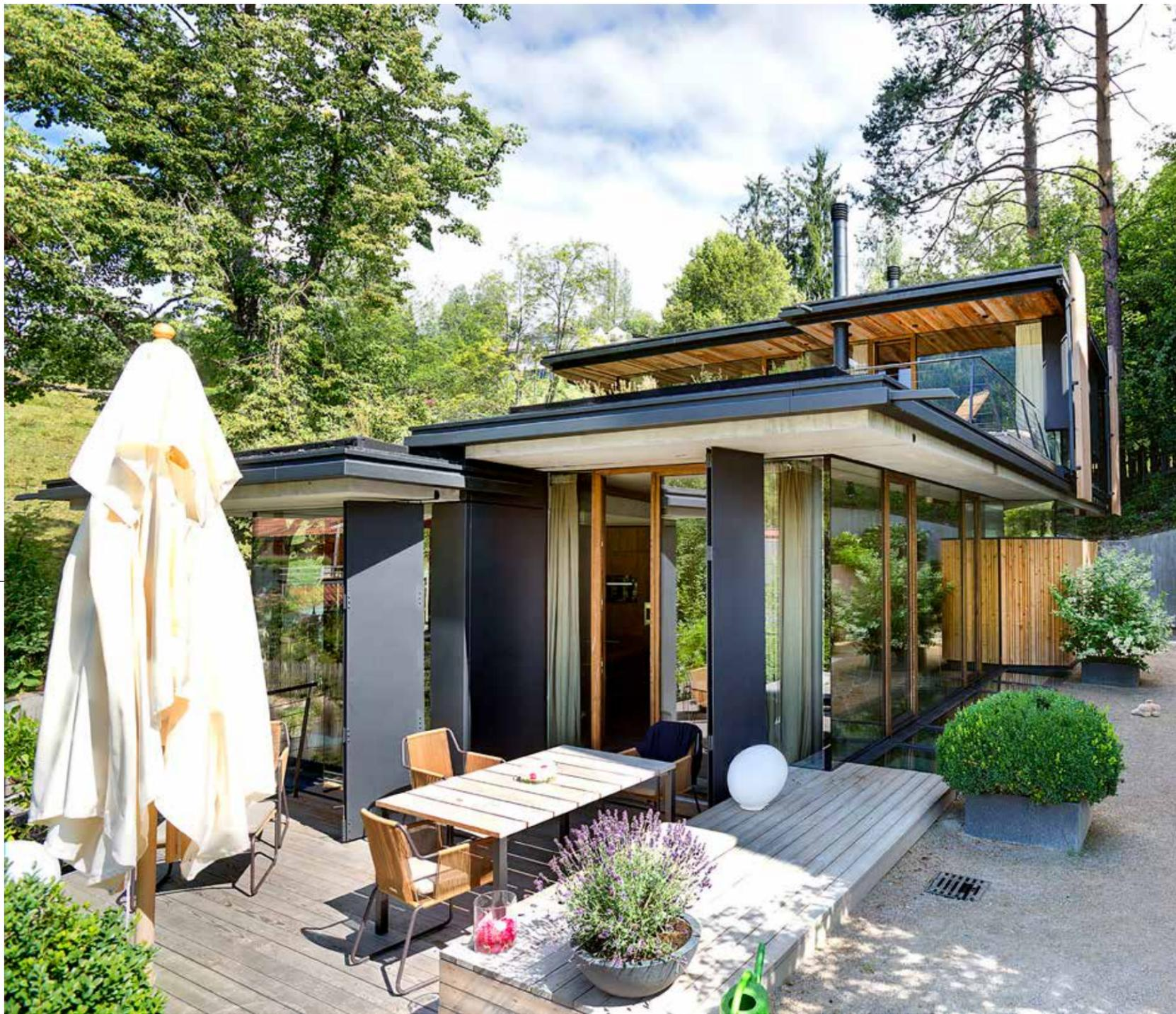
Für die großflächigen Außenschalungen und Terrassenböden kam spezielle Thermokiefer zum Einsatz.
